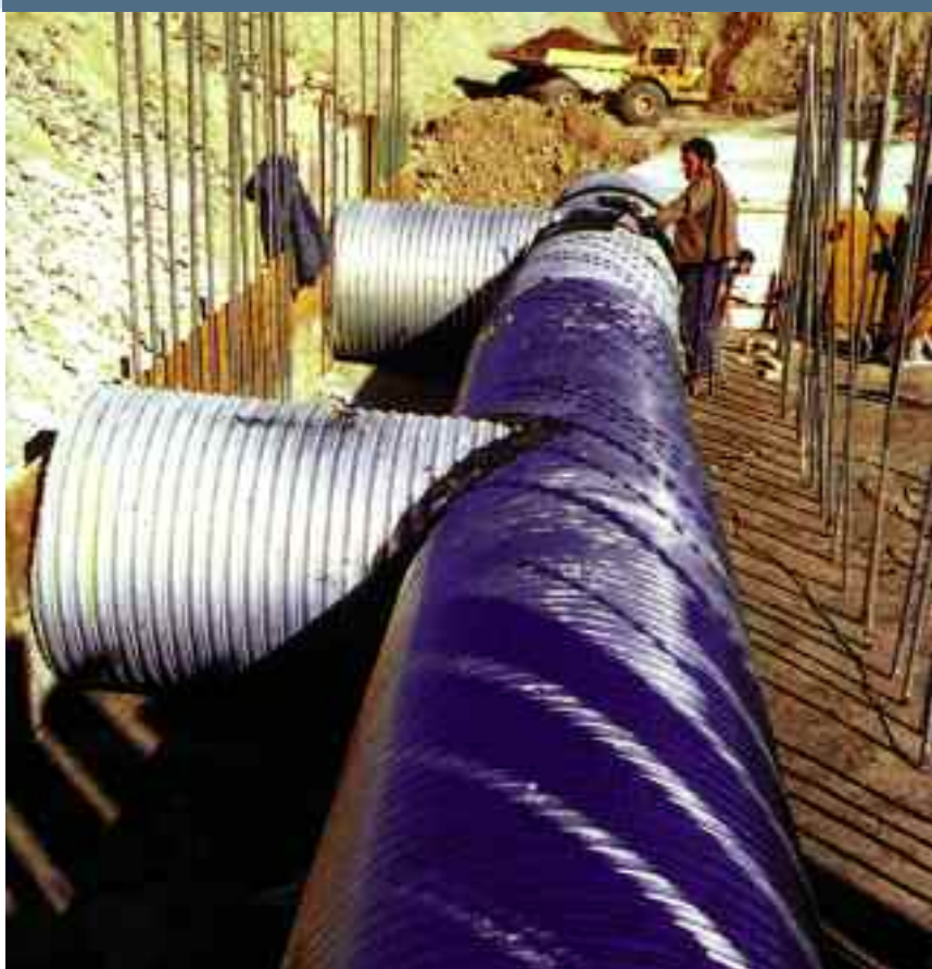
Sistema di tubi a maglia ortogonale per la raccolta ed il convogliamento delle acque filtrate attraverso il terreno.
