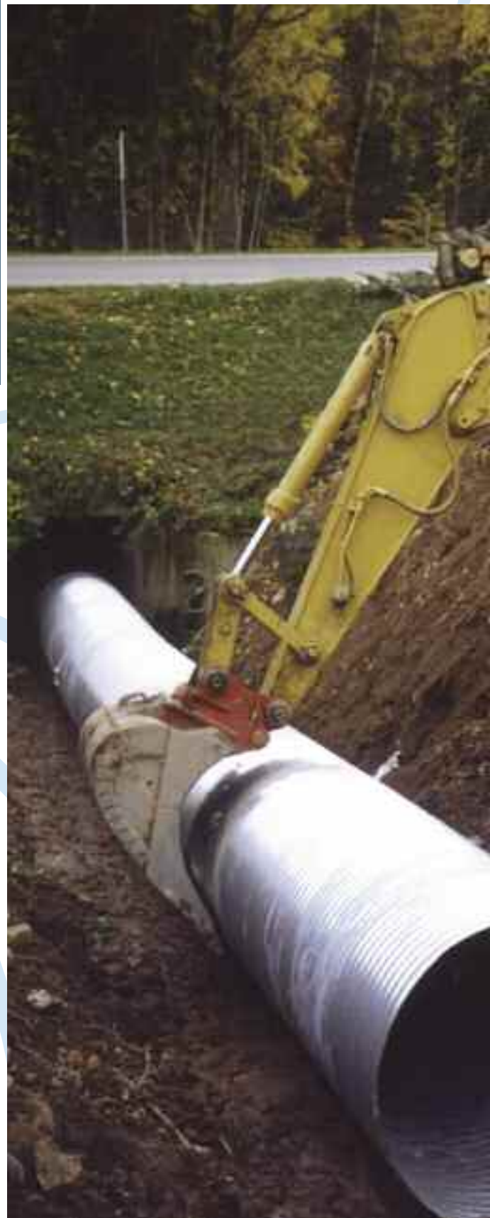
Sistema di tubi a maglia ortogonale per la raccolta ed il convogliamento delle acque filtrate attraverso il terreno.
